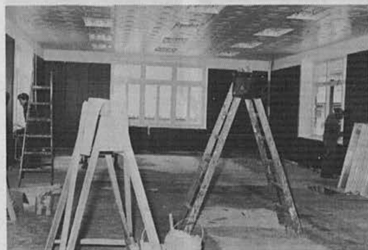
Nekdanja Sindikalna dvorana je spet obnovljena – tokrat za interne potrebe Alpine
