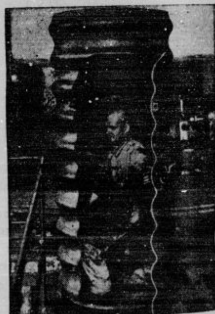
V trenutku, ko sovražna letala približno nad Berlin, ne morejo vsi ljudje zbežati v večja zaklonišča, pa pa jih mora mnogo ostati za vsak primer v bližini važnih industrijskih in drugih naprav. Da bi poskrbeli tudi za varnost teh, so v Nemčiji začeli graditi takšne majhna jeklena zavetišča, kjer je prostora samo za enega moža. V njem je človek varen pred drobcem bomb in pred kamenjem, ki po eksploziji trči po zraku.
