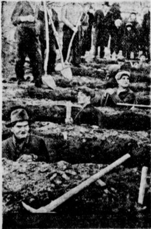
Na pokopališču v Oseku kopljejo grob 13 rudarjem. Ostalih 140 je bilo za vedno pokopano v rudniškem rovu
