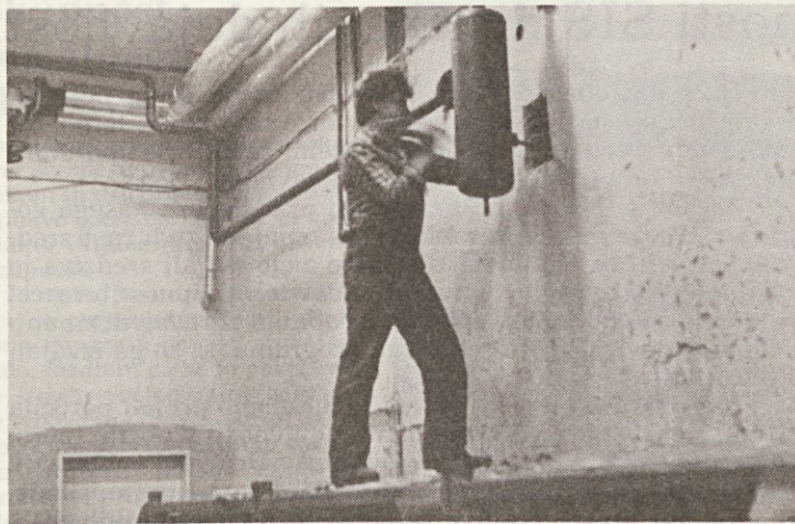
Montaža cevovoda za komprimirani zrak v oddelku predpredilnice bombaža
