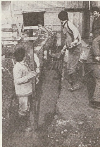
Potrebno je bilo prekopati cesto pred sukalnico in zgraditi betonsko kineto
