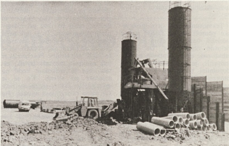
Betonarna na gradbišču v Kirkuku (Foto: M. Čepuran)
