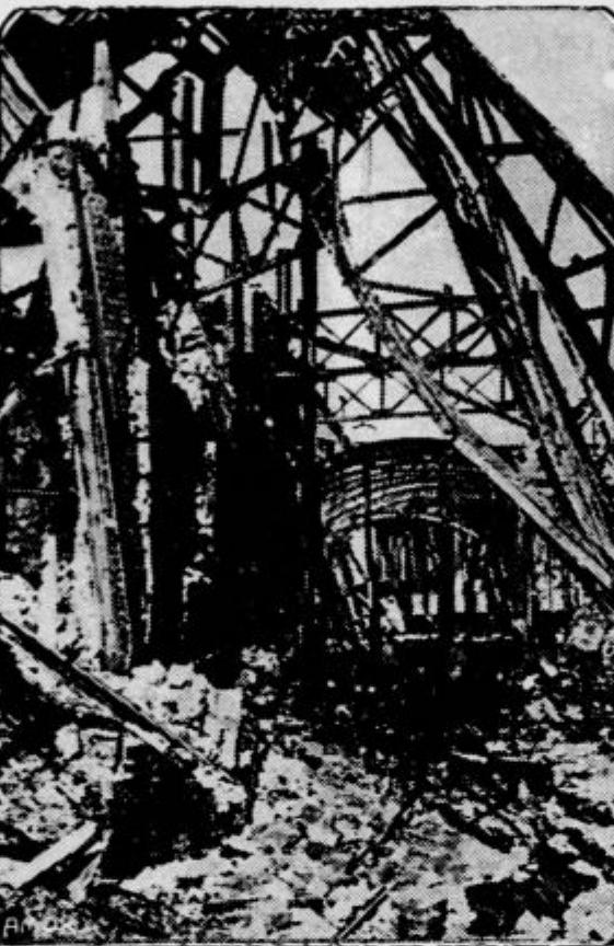
Razdejanje neke tvornice na Angleškem
