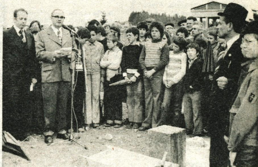
Slavko Malgaj je skupaj z delavcema SGP Gradbinec vzdal temeljni kamen za novo šolo na Planini. – Foto: F. Perdan
