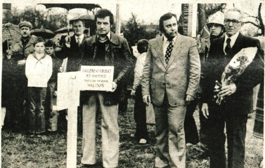
Mavčiče — V sredo, 26. aprila so v krajevni skupnosti Mavčiče slovesno položili temeljni kamen za družbeni objekt krajevnih skupnosti. Tako bodo dobili samopostrežno trgovino, otroški vrt in družbene prostore krajevnih skupnosti, obenem pa tudi prostore pošte. S telefonsko centralo se obeta prihodnjim telefonskim naročnikom na desnem bregu Save tudi več telefonskih priključkov. — Foto: F. Perdan
