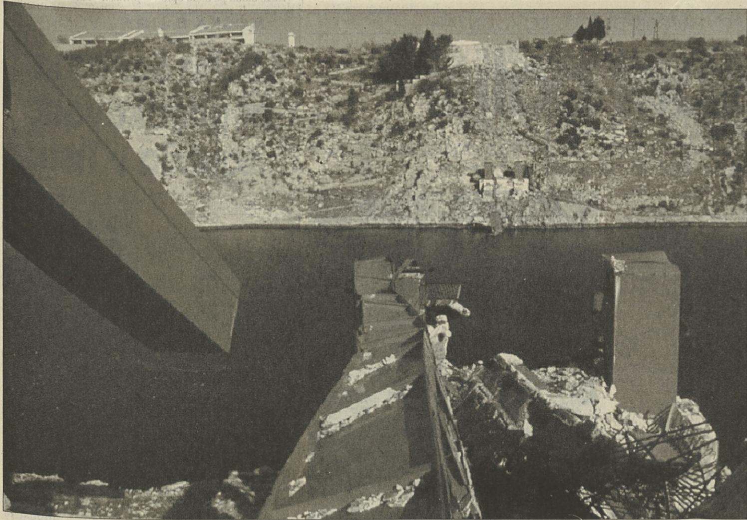
Srbska vojska je uničila prometne in energetske povezave Dalmacije s svetom. Na sliki: ostanke Maslenskoga mostu.
