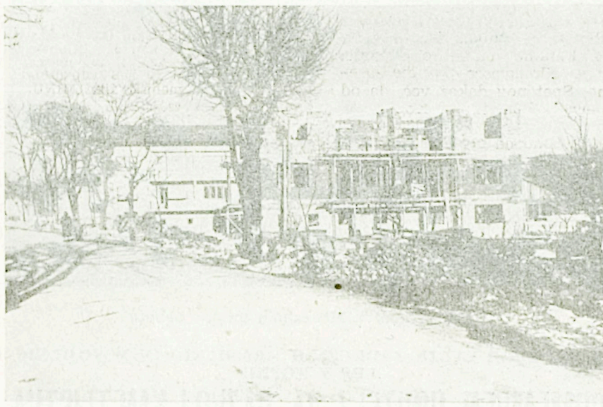
Tretji petorček v Divači bo kmalu pod streho. Ta petstanovanjski blok gradi podjetje Elektro-Sežana za tiste svoje delavce, ki so zaposleni pri veliki razdelilni transformatorski postaji v Divači
