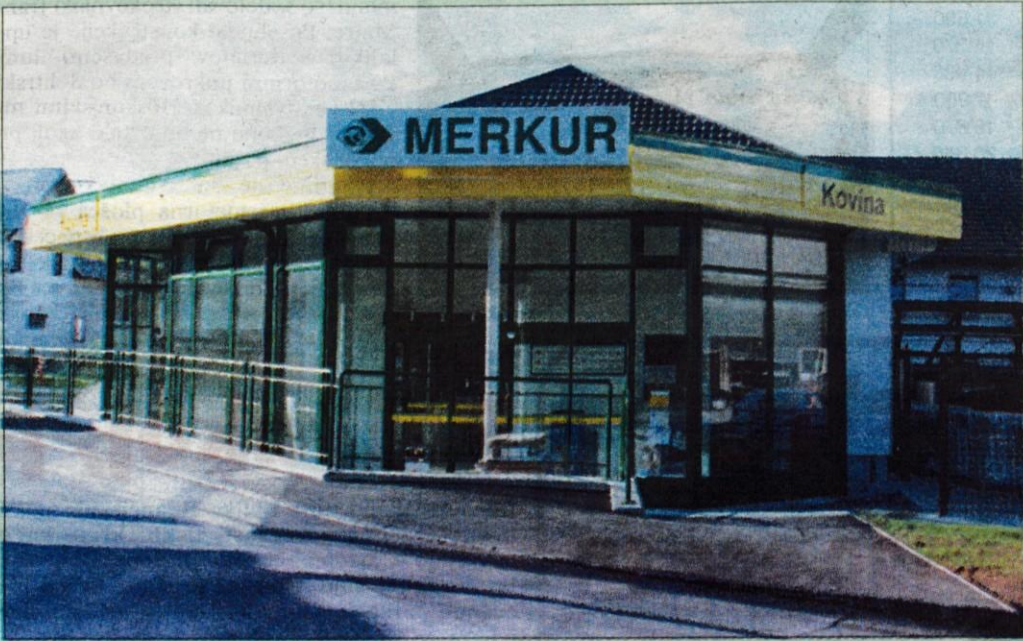
Pročelje prenovljene Kovine.
