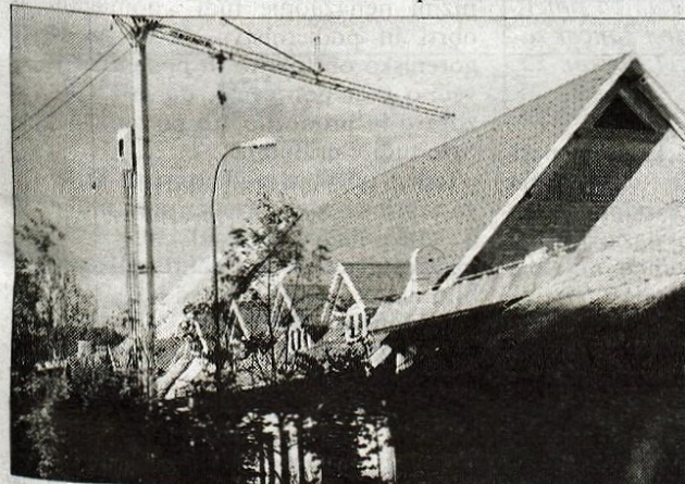
Postavitev novega ostrešja na delu tovarne ob cesti v Vinarje že kaže na to, kako bo spremenjena, okolju in tisočletnemu mestu prijaznejša nova zunanja podoba.
