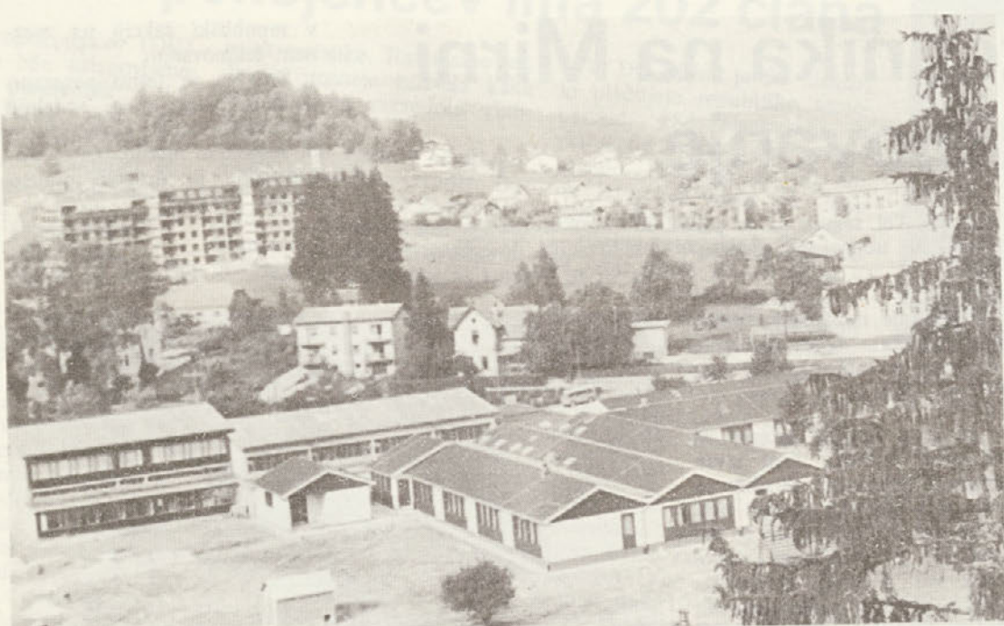
Pogled na šolo z novim prizidkom.
