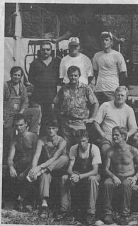
Ekipa Primorja, ki je asfaltirala žirovske ceste
