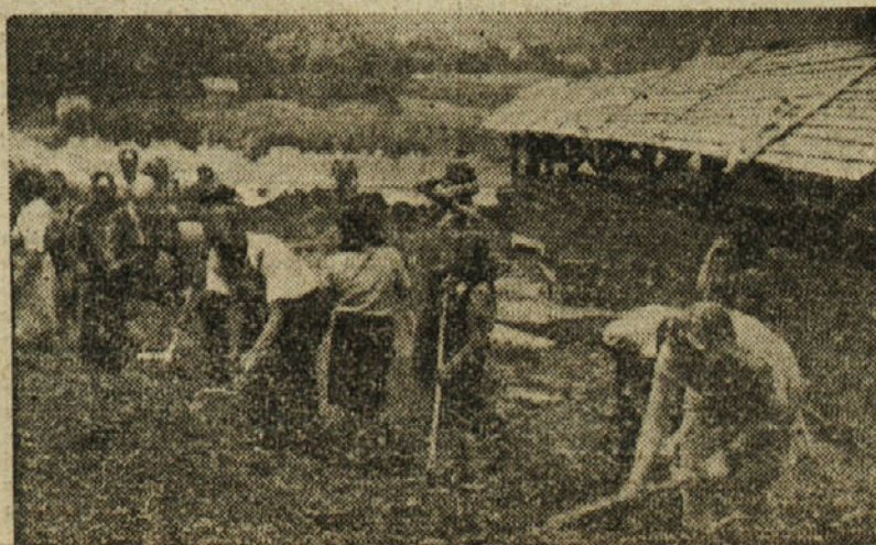
Izkop in čiščenje terena za gradbo opečnih sušilnic
