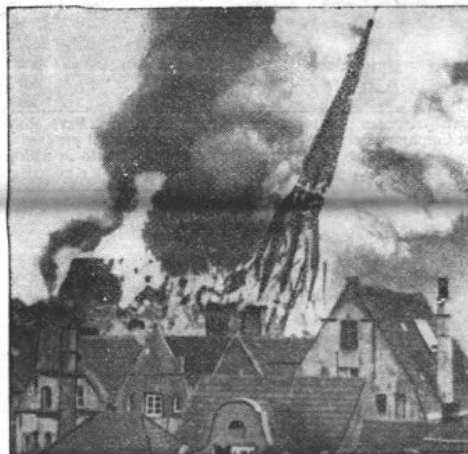
CERKVENI STOLP SE PODIRA . Starodavna cerkev v Em- denu (iz l. 1317.) je nedavno zgorela. Fotograf je ujel na ploščo položaj v trenutku, ko se je nagnil cerkveni stolp
