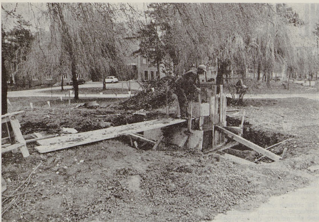
Gradnja kanalizacije za novi blok
