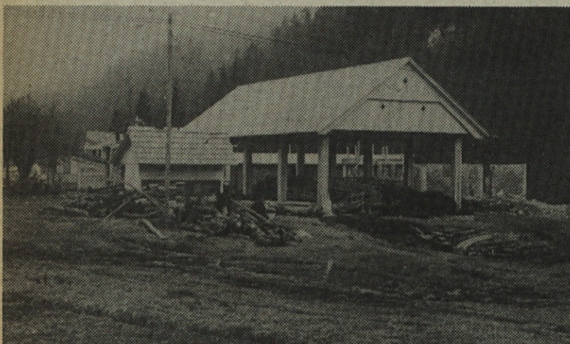
Pripravljalna dela na RUŽV obsegajo tudi rušenje starih in gradnjo novih kmetij s pripadajočimi objekti
