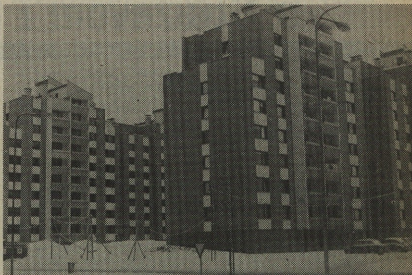
Gradnja 120 stanovanj v Žalcu je pred zaključkom
