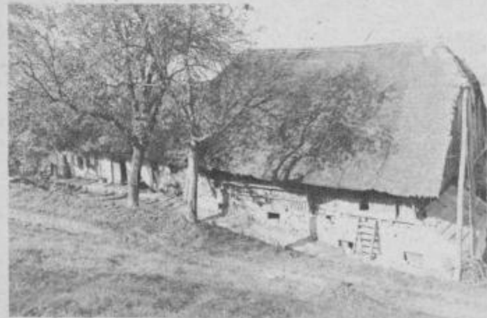
Značilna hribovska domačija v kateri so si pred napeljavo električnih vodov svetili s tokom iz zasebne hidrocentrale.
