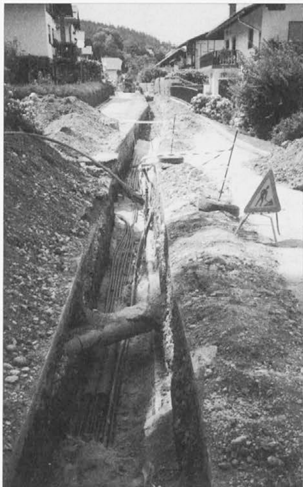
Izgradnja povezovalnega plinovoda Šance–Janeče v avgustu 2004
