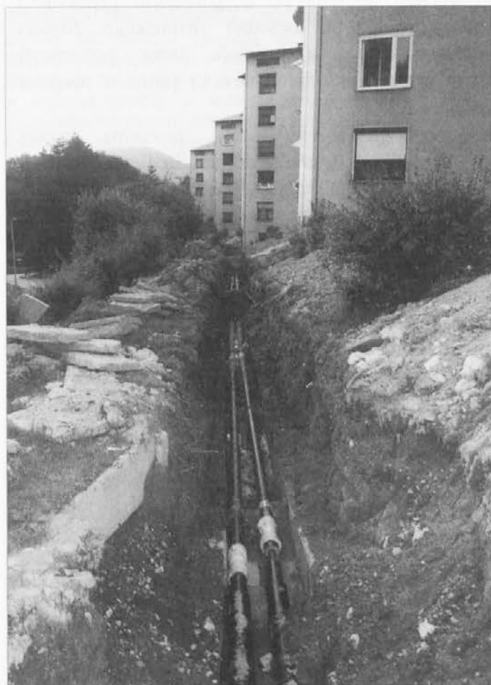
Obnova omrežja daljinskega ogrevanja na Čečovju v juniju 2004
