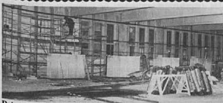
Dela pri gradnji nove hale gredo h koncu
