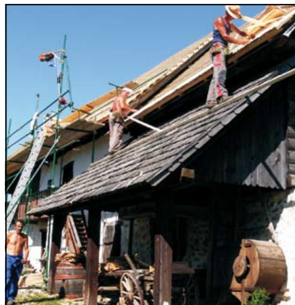
Budnarjeva muzejska hiša v Palovčah je dobila novo streho, obnovljena je bila tudi črna kuhinja, september 2009.
