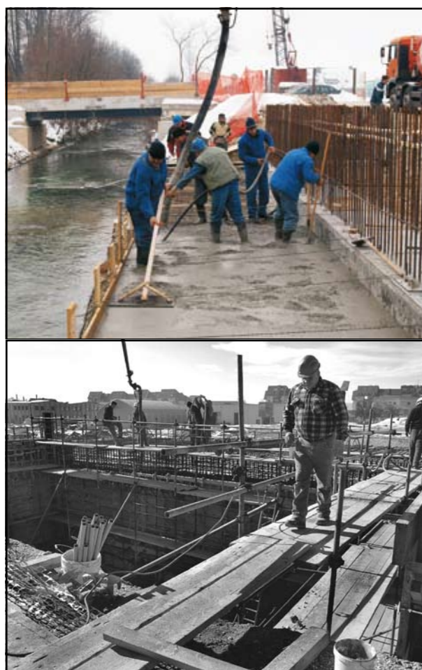
Gradnja Povezovalne ceste treh mostov, januar 2010. Foto: Dušan Letnar.
