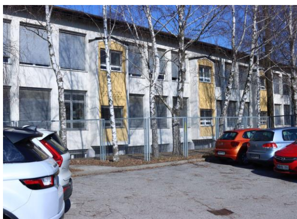
Slika 3: Fasada škole nakon energetske obnove.
