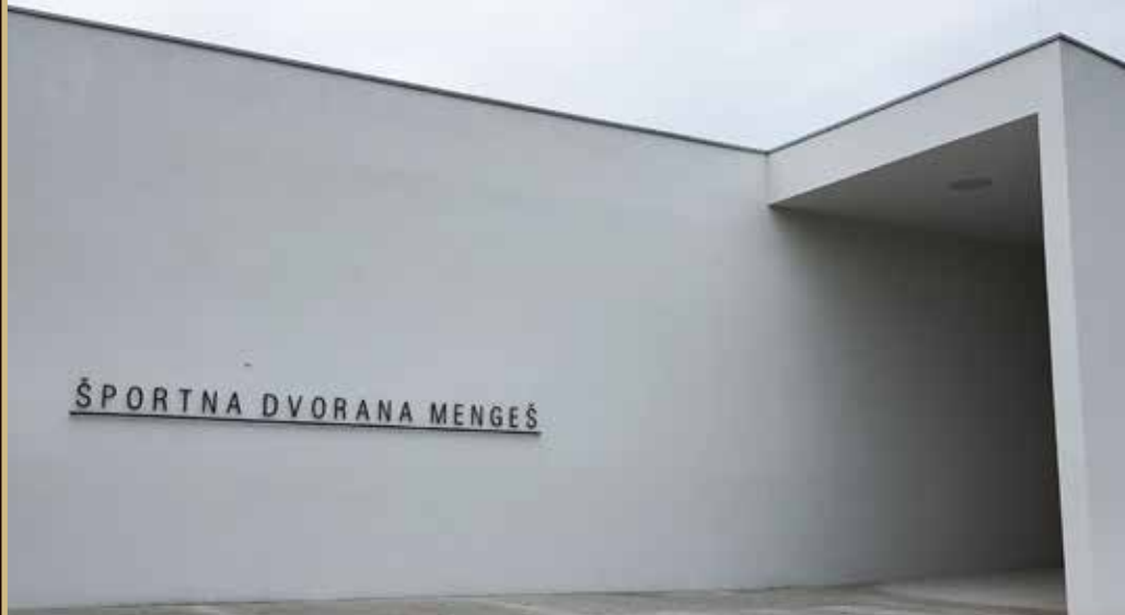
Vhod v Športno dvorano Mengeš je z urejenega parkirišča, namenjenega tako osnovni šoli kot uporabnikom dvorane v popoldanskem času
