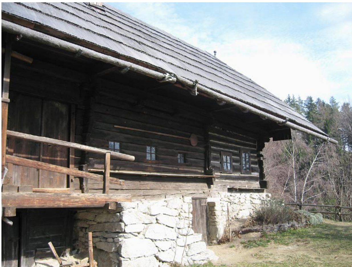
■ Slika 1: Kavčnikova (pri Kavčeli) dimnica v Zavodnju nad Šoštanjem iz 17. stoletja sodi med najjužneje ohranjeno alpsko dimnico v Evropi. Tristrano obdelana bruna se povezujejo z utori na križ (foto: Vito Hazler).
