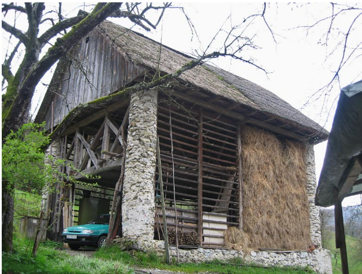
■ Slika 4. S slamo prekrit kozolec na domačiji Dolenji Novaki 5 na Cerkljanskem ima nosilne stebre okrogle in pozidane s kamnom, vsi drugi konstrukcijski in sušilni deli kozolca so leseni (foto: Vito Hazler).
