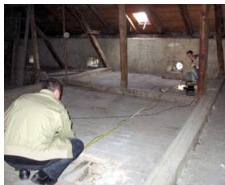
ultrazvočna meritev na stropniku
