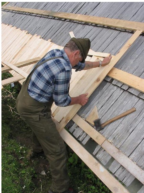
■ Slika 5. Še tako popolno teoretično in v šoli pridobljeno tehnično znanje ne uspeva povsem nadomestiti izročila veščin obdelave avtohtonih gradiv. Pridobivanje in obdelava lesa za skodle so veščine, ki terjajo desetletne izkušnje. Skodlar z Velike Planine do popolnosti pozna vse tiste lastnosti lesa, da bo skodlasta streha na pastirskem stanu zdržala vsaj eno ali dve desetletji (foto: Vito Hazler).
