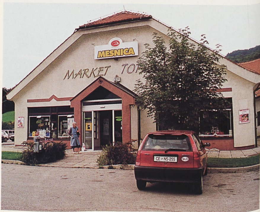
Samopostrežba v Podčetrtku bo prva na vrsti za prenovu
