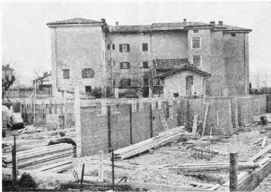
Ob starem dotrajanem Zavodu sv. Družine rastejo temelji bodočega sodobnega zavoda. Kot v preteklosti bo mogoče to veliko delo dokončati le z odprtim srcem in darežljivo roko slovenskih dobrotnikov
