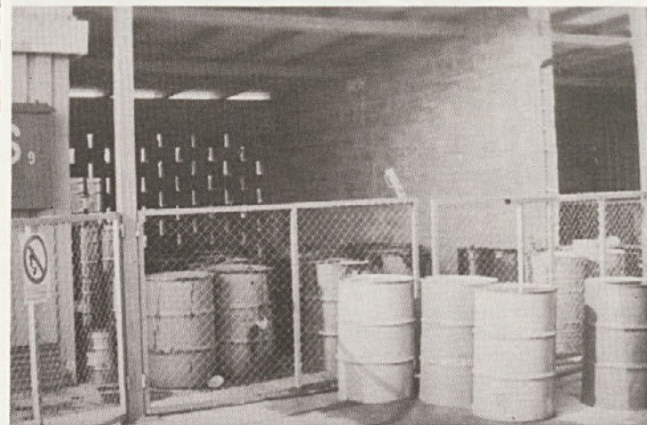
Dokaj urejeno skladišče vnetljivih tekočin
