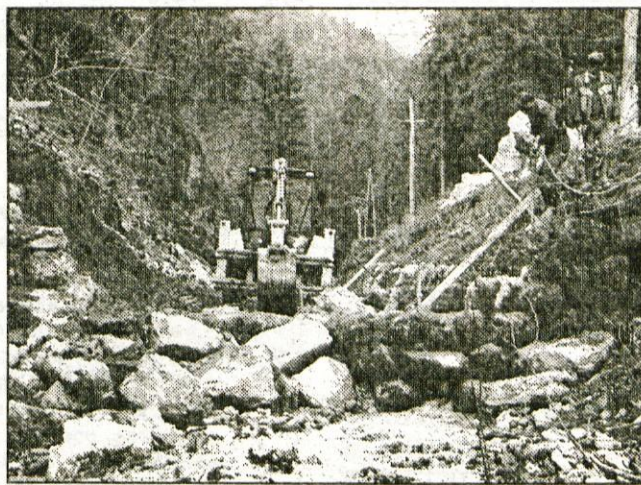
Podiranje 73 let starega kamnitega jezu, ki so ga izgradili Italijani, ni niti najmanj lahko opravilo.
