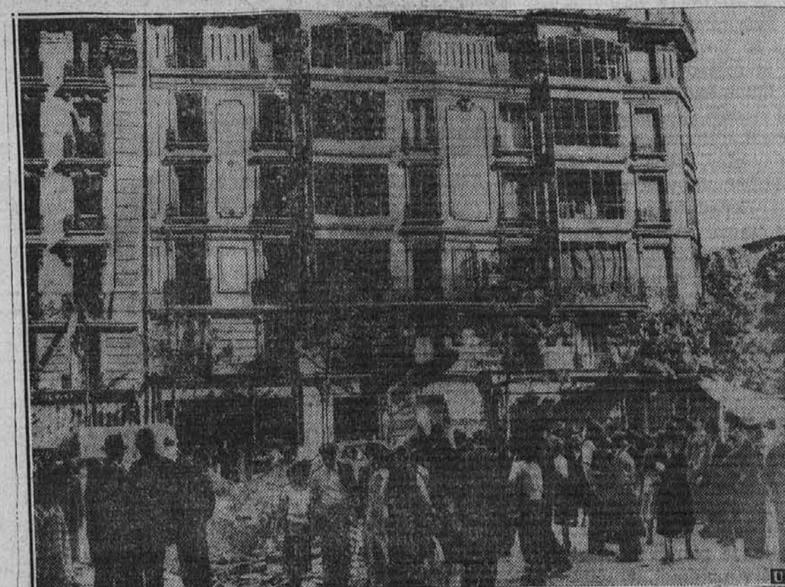
Malokatero poslopje je ostalo nepoškodovano v okolici, kjer so padle nemške bombe. Parizani si ogledujejo škodo, ki so jo povzročile nemške bombe ob prvili prvega zračnega napada na Pariz. Mnogo poslopj je bilo popolnoma porušeno.
