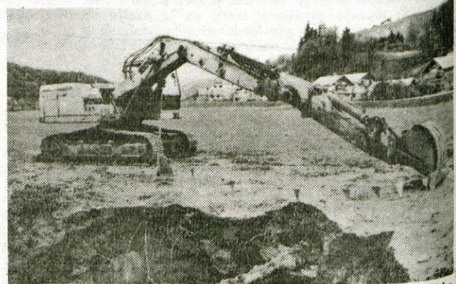
Gradnja primarne kanalizacije poteka po programu in z velikim razumevanjem krajanov.
