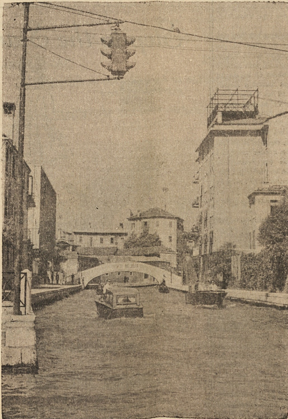
PROMETNA LUČ NAD VODO — V Benetkah je večina mestnega prometa na vodi, tako so namestili na križiščih zelo prometnih kanalov prometne luči, kot smo jih pri nas vajeni nad cestnimi križišči.
