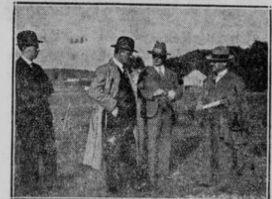
Ban dr. Marušič ob postavljanju stebra. Od desne na levo stoje: ing. Ruch, ing. Miklavc in dr. D. Marušič s tajnikom.
