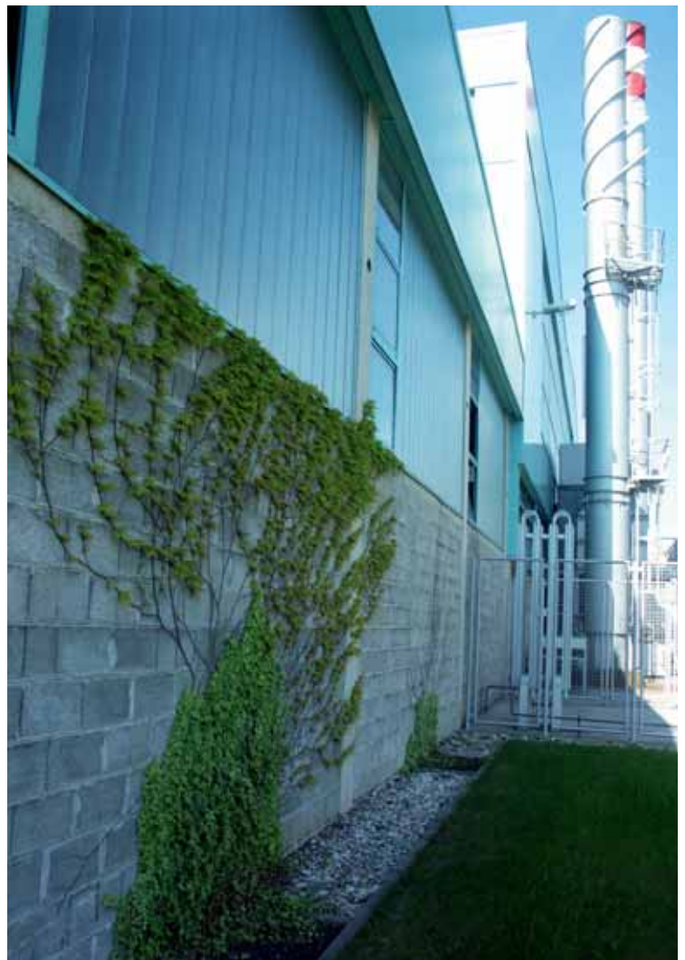
Čistilna naprava v livarni
