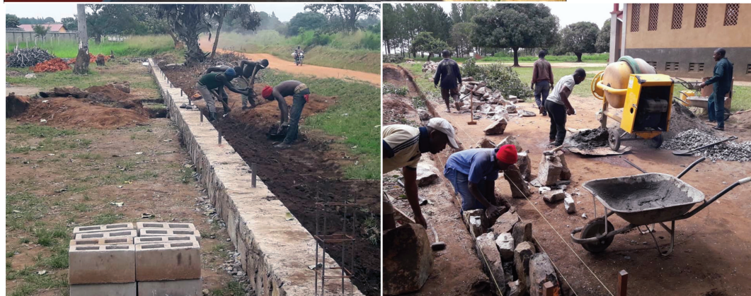
Nova šola in gradbišče za novo bolnišnico, ki bo zgrajena na lokaciji stare šole. Prostor smo zagradili in v februarju bomo že začeli zčasno ambulantno medtem, ko v bližini raslo novo poslopje bolnišnice.
