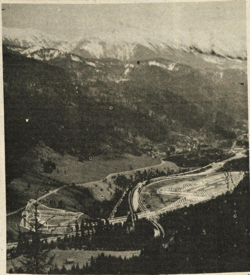
KARAVANŠKI PREDOR nameravajo zgraditi do leta 1985, v tem času pa po odsekih graditi tudi avtocesto po Gorenjski. Pred predorom na Hrušici pri Jesenicah bodo morali regulirati Savo, zgraditi most ter nadaljevati z avtocesto po pobočjih Mežakle. Na mejnem platoju na Hrušici bodo opravljali vso mejno carinsko službo za obe mejni državi, Avstrijo in Jugoslavijo.
