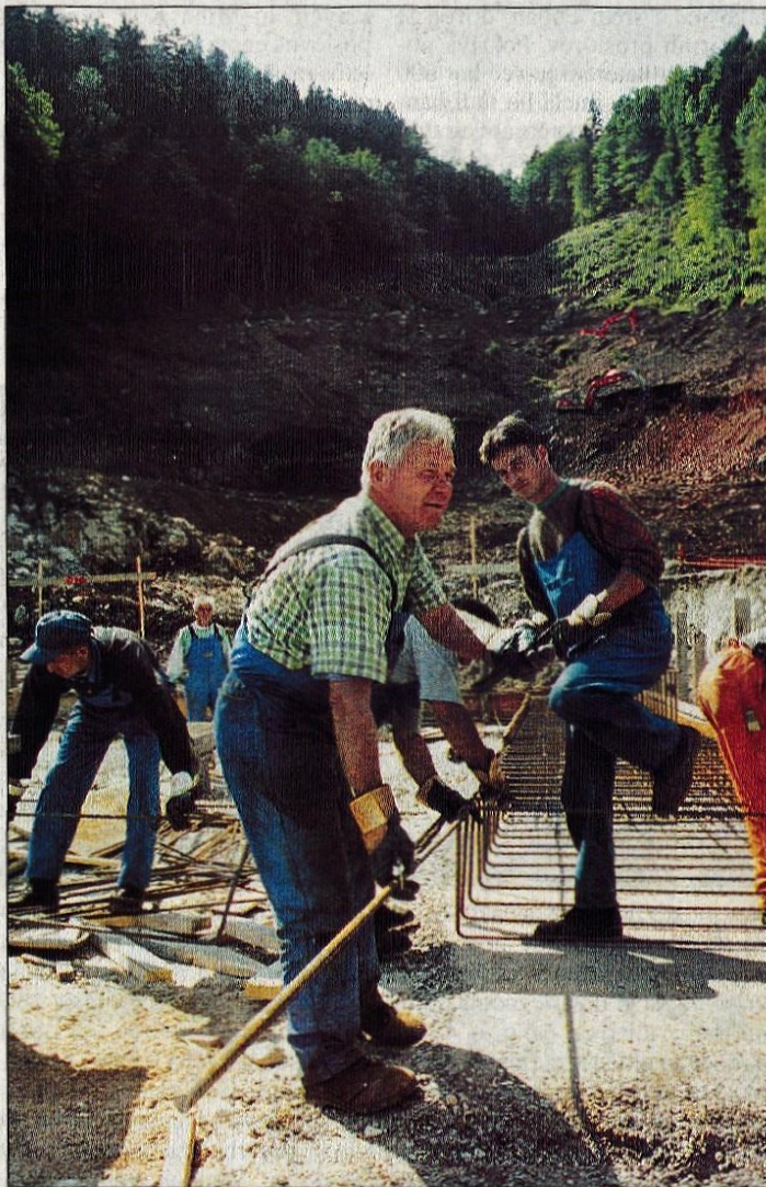
Pripravljalna dela na skakalnici pod Šmarjetno goro so se začela že avgusta, po načrtih pa naj bi prve treninge na njej skakalci opravili že to zimo. foto: G. Kavčič
