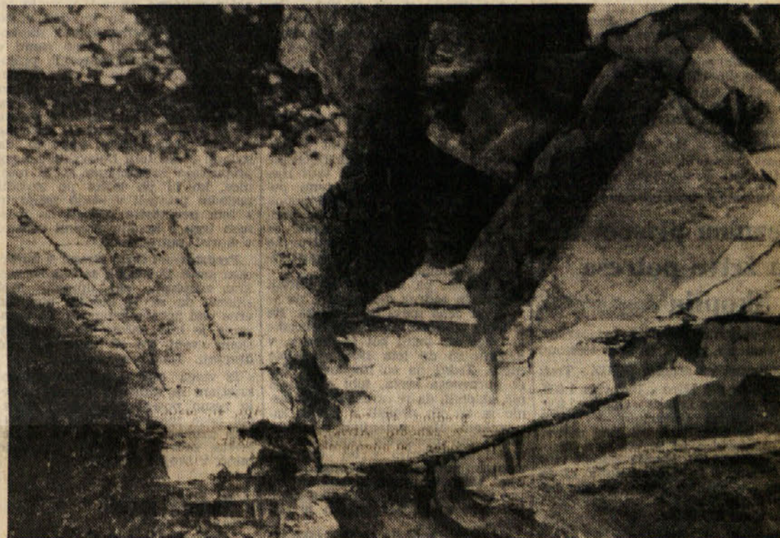
Hudournik je tako razdejal 300-400 m poti v Piscalon. Skale je voda strgala, odnesla je cestno podlago v globini 2-3 m in širini 3 m
