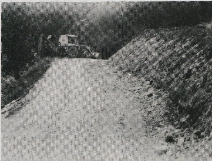
V najmanjši krajevni skupnosti – Česnjice – ne mirujejo. Opravljena so že vsa zemeljska dela, s katerimi so razširili cesto do Poljane in Selc. Sedaj kopljejo prepuste, polagajo cevi in betonirajo jaskhe. Domačini upajo, da se bo v občinski blagajni našlo kaj tolarjev za asfalt.
