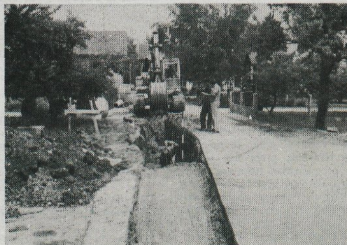
Bodo v Loki ob pomoči DODATNEGA SAMOPRISPEVKA lažje dokončali sekundarno kanalizacijo do konca 1994. Kaže da!
