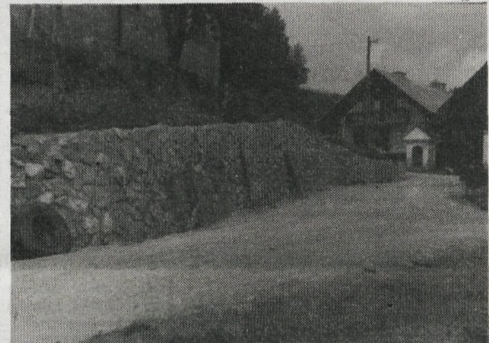
200m 3 kamena in nekaj manj kubikov betona sestavlja oporni zid na Malem Jelniku
