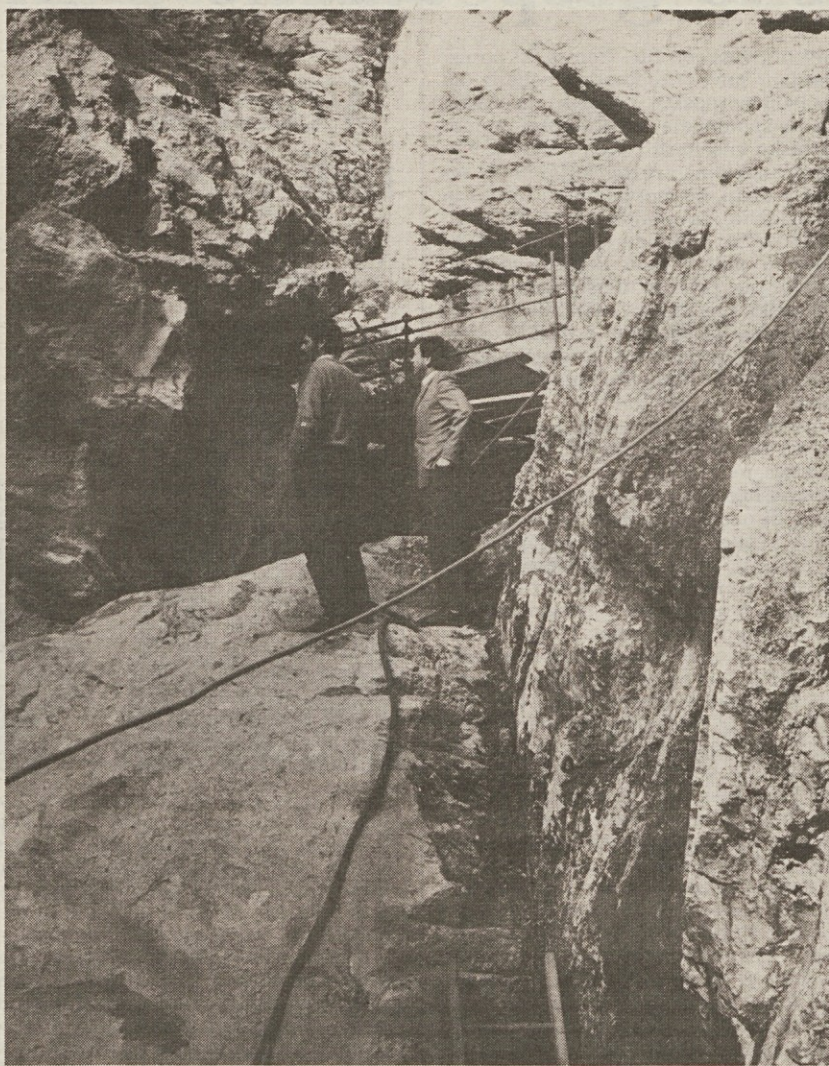
Še zadnja dela v soteski Pasice
