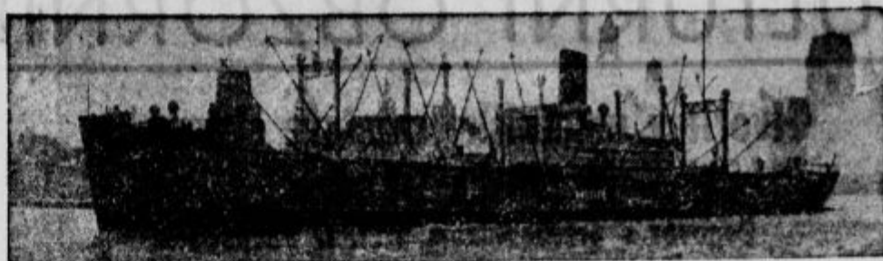
Prvo ladjo take vrste so zgradili Američani. Ameriški tovorni parnik »Marmacoon« je prva ladja, na svetu, ki njene plošče niso prвите na ladijski trup, kakor je bilo doslej, marveč so zvarjene. Ladja je 149 metrov dolga ter naloži lahko 11.266 ton blaga.
