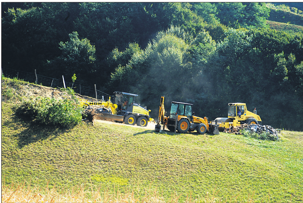
Podjetje Asfalti iz Ptuja je prejšnji teden pričelo zemeljska dela za modernizacijo javnih poti na Goričaku.
