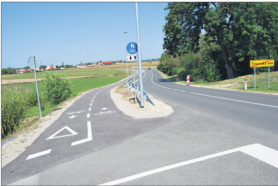
Gradnja kolesarskih stez se je zaključila avgusta.
