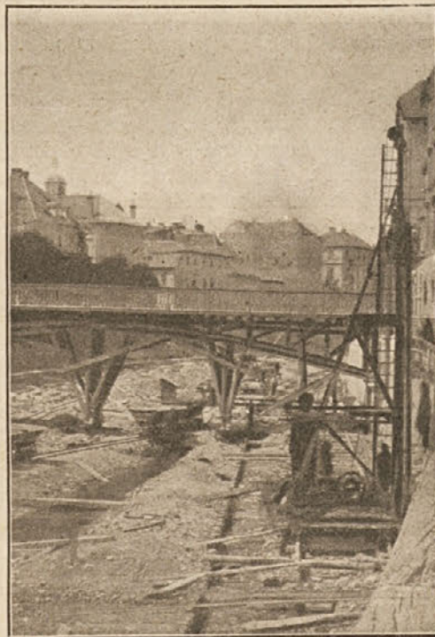
Regulačna dela v Ljubljani: Stroj za zabijanje pilotov ob Tranči.
