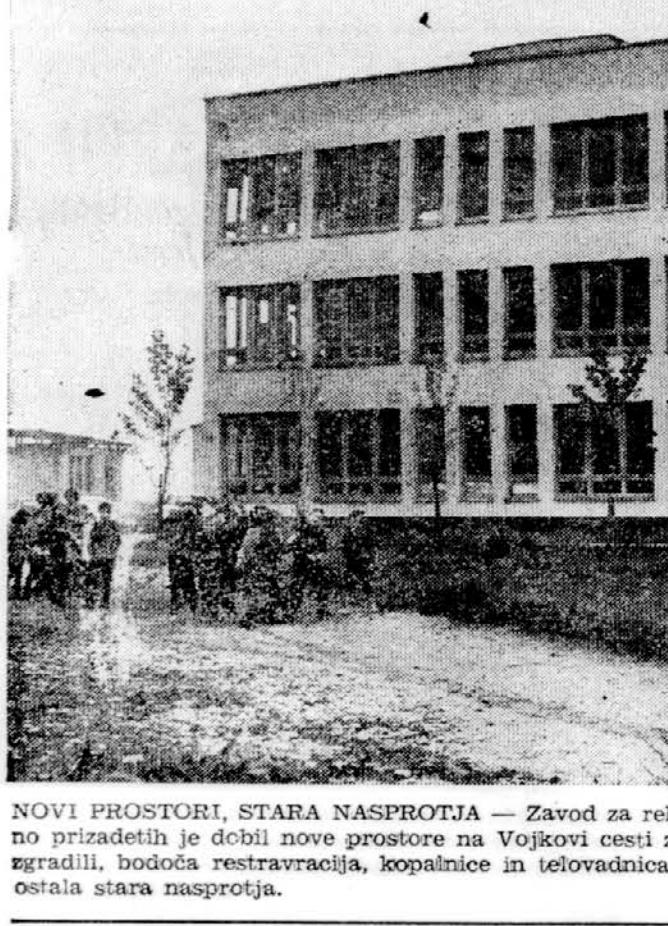
NOVI PROSTORI, STARA NASPROTJA — Zavod za rehabilitacijo slušno in govorno prizadetih je dobil nove prostore na Vojkovi cesti za Bežigradam. Nekaj so že zgradili, bodoča restravracija, kopalnice in telovadnica so še v gradnji. Za pa so ostala stara nasprotna. Foto: M. Svabič
