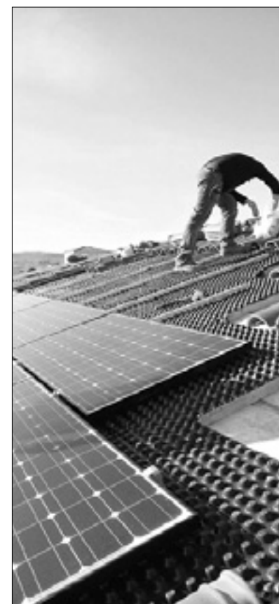
Gradnja sončne elektrarne
