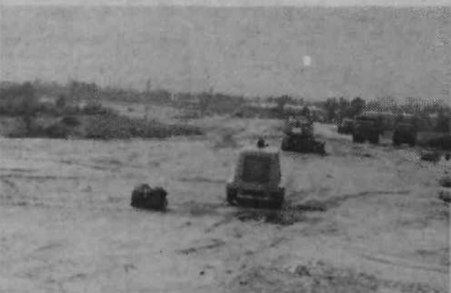
Tudi levo od Titove ceste s štajerske strani je trasa, ki vodi mimo črnuške industrijske cone, že lepo vidna. Močvirnati teren z ilovico gradbenikom ni naredil preveč težav, le nadvoz nad kamniško progo bo stal na 25 do 30 metrov dolgih pilotih.
