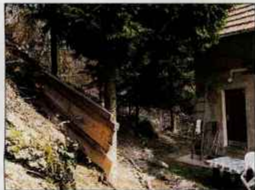
Vhod v hišo do odstranitve skal ščiti lesena pregrada.
