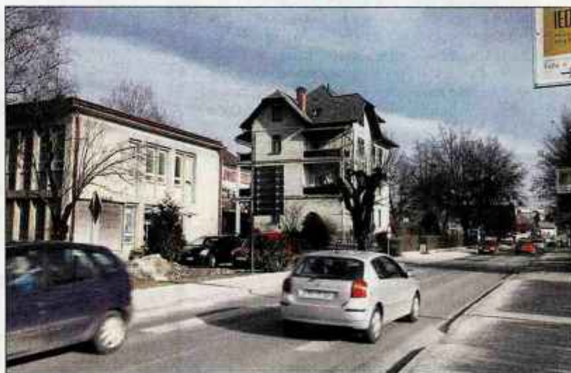
Prešernova cesta skozi Bled je obnovljena, Gratel in Občina Bled pa se ne moreta dogovoriti, kdo bo plačal del stroškov. / Foto: Anja Bulovec
