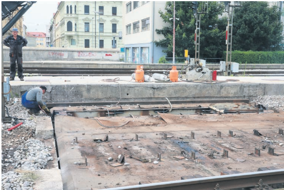
Gradbeni poseg pri obnovi mostovne konstrukcije na podvozu pri železniški postaji je sicer zelo zahteven, a kljub temu v Celju že nestrno pričakujejo dokončanje del in normalizacijo prometa na tem območju.
