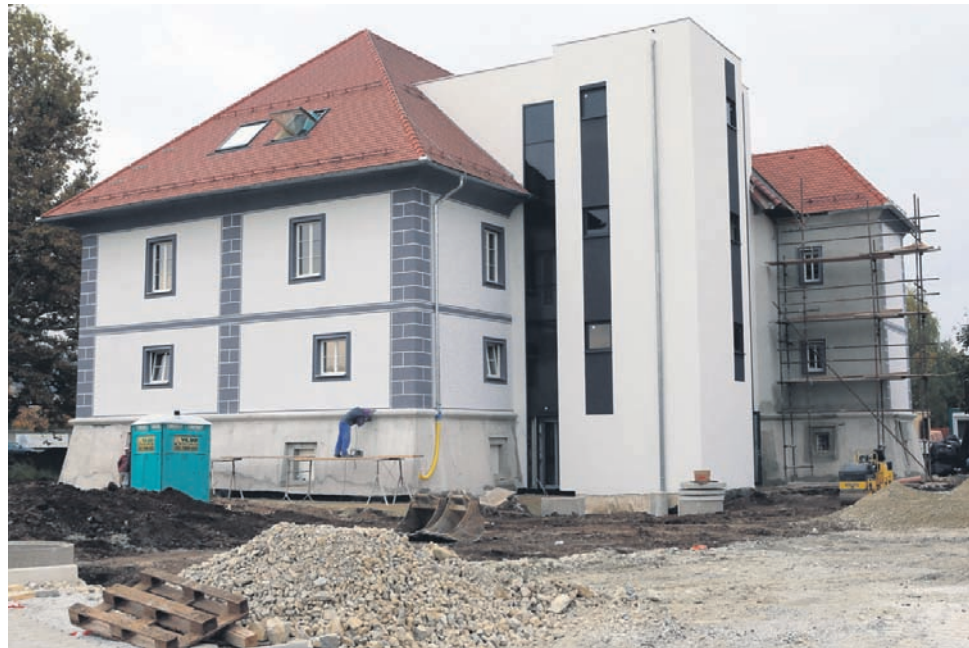
Obnova dvorca Lanovž, v katerem bo odslej sodobno medicinsko središče, se pospešeno bliža koncu.
