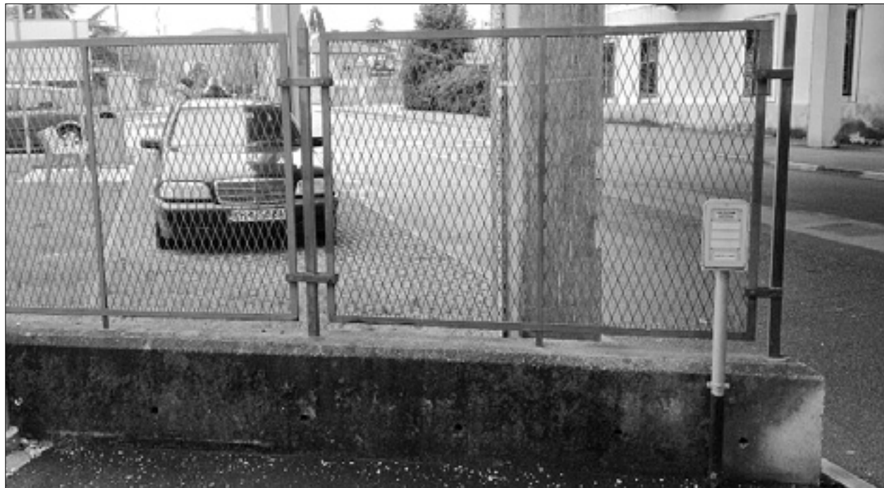
Betonski zidek na nekdanjem mejnem prehodu Škabrijelova-Erjavčeva
