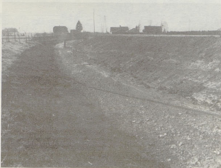
Razbremenilni kanal Ložnice na Polzeli je lepo očiščen in urejena bregova.
