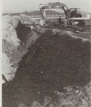
Za namakanje njiv levo od ceste Polzela-Šempeter so skopali pri Čulku v Ločici pod cesto rov za dovodno cev.
