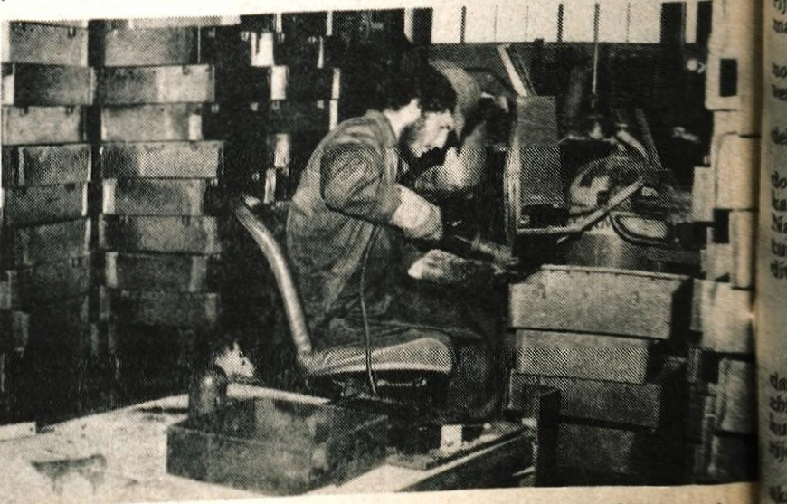
Pogled v del proizvodne hale ELIM na Hrušici, kjer sestavljajo omarice stikalne naprave – Foto: S. Saje
