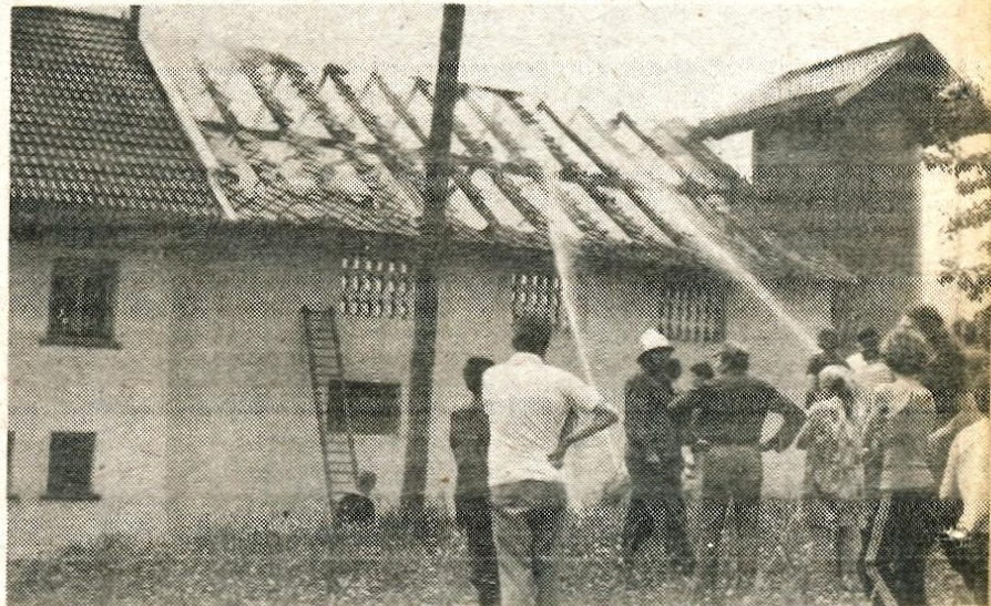
Naklo — V sredo, 30. maja, nekaj po 14. uri je zagorel senik Marije Jagodice v Cegelnici. Ogenj je uničil ostrežje, pogorelo je 3,5 tone sena, naprava za sušenje sena in nekaj orodja. Delno je poškodovano tudi ostrežje stanovanjske hiše. Škoda je za okoli 500.000 din. Ogenj je zanel otrok, ki se je na senu igral z vžgalicami. Ogenj so pogasili kranjski poklicni gasilci in prostovoljni gasilci iz Naklega. — Foto: Z. J.
