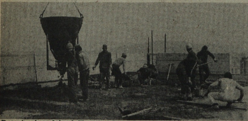
Betoniranje zadnje plošče na poslovnem centru Emona
