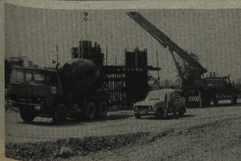
Betoniranje na nadvozu »4 — 3« v Brezovici
