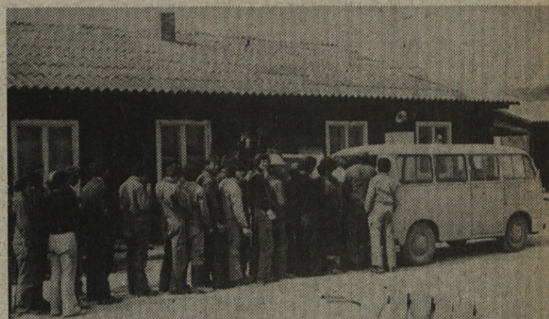
Kombi z malico je prispel na gradbišče koprskega nadvoza
