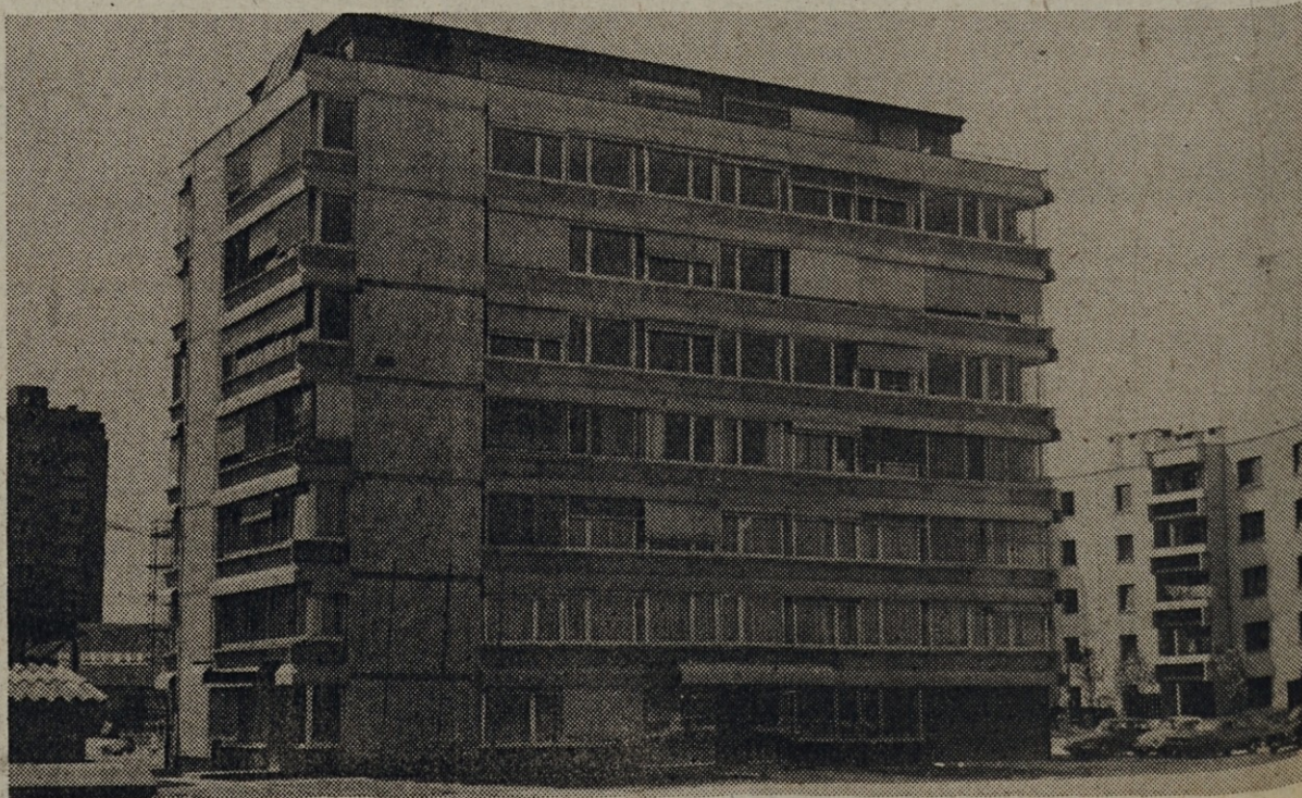
Taka je nova poslovna stavba Biroja za projektiranje Ljubljane in TOZD GE Ljubljana — okolica
