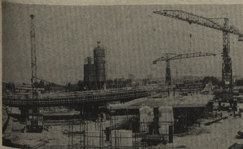
Sodobno križišče bo omogočalo hitrejši potek prometa na vhodu v Koper
